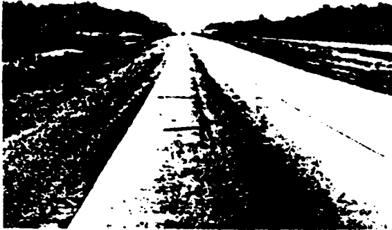
Fig. 3.2.4.1 — Longitudinal cracks
